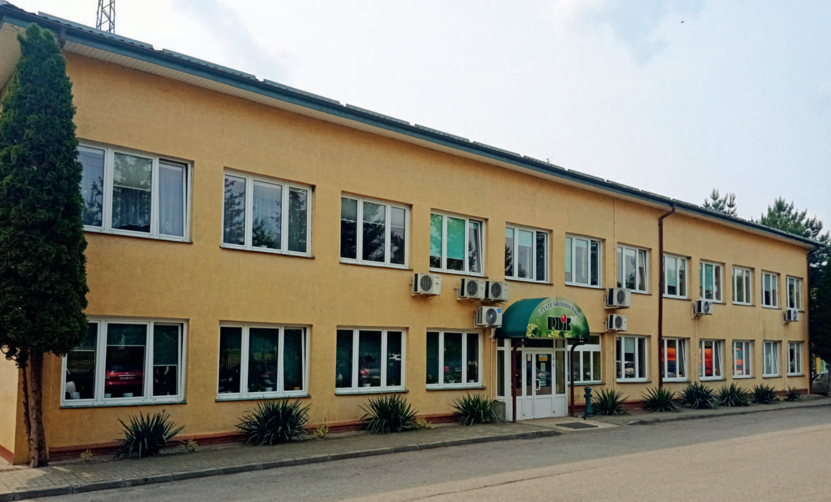
Budynek administracyjny przy ul. Kosowskiej 75
